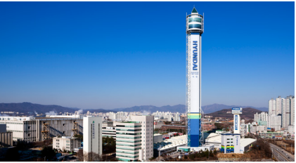
건축 연면적 4,351㎡, 205m로 당시 세계 최고 높이 엘리베이터 테스트타워 건설
